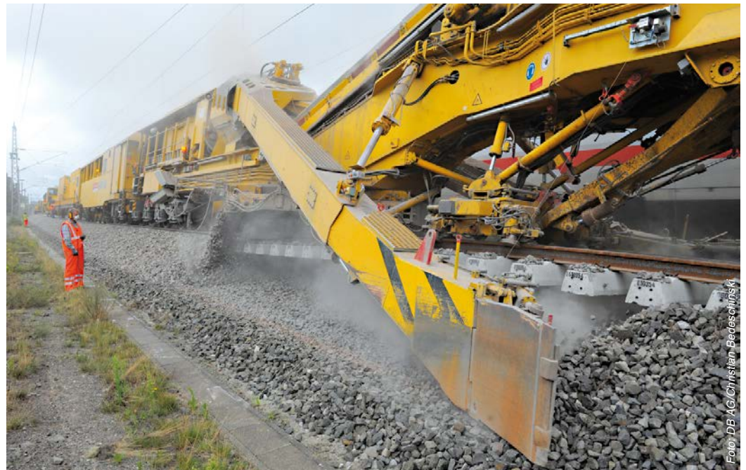
Die DB bereitet zu erneuenden Schotter auf und setzt ihn als Recyclingschotter wieder ein
